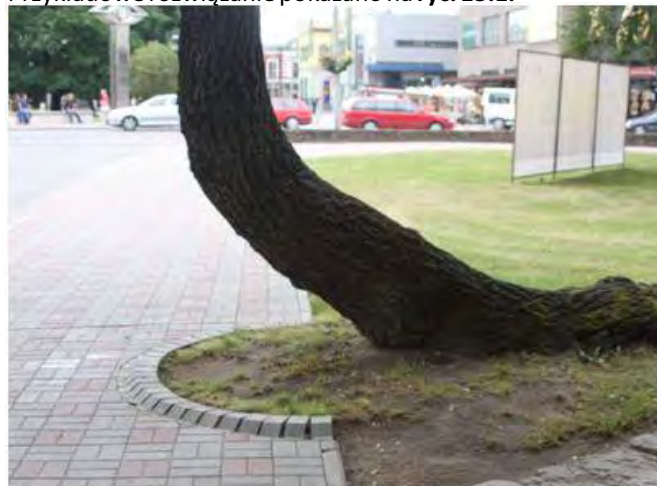
Ryc. 13.1. Wyznaczenie krawężnikiem miejsca ominięcia przeszkody w obrębie ciągu pieszego (zdj. autora)
